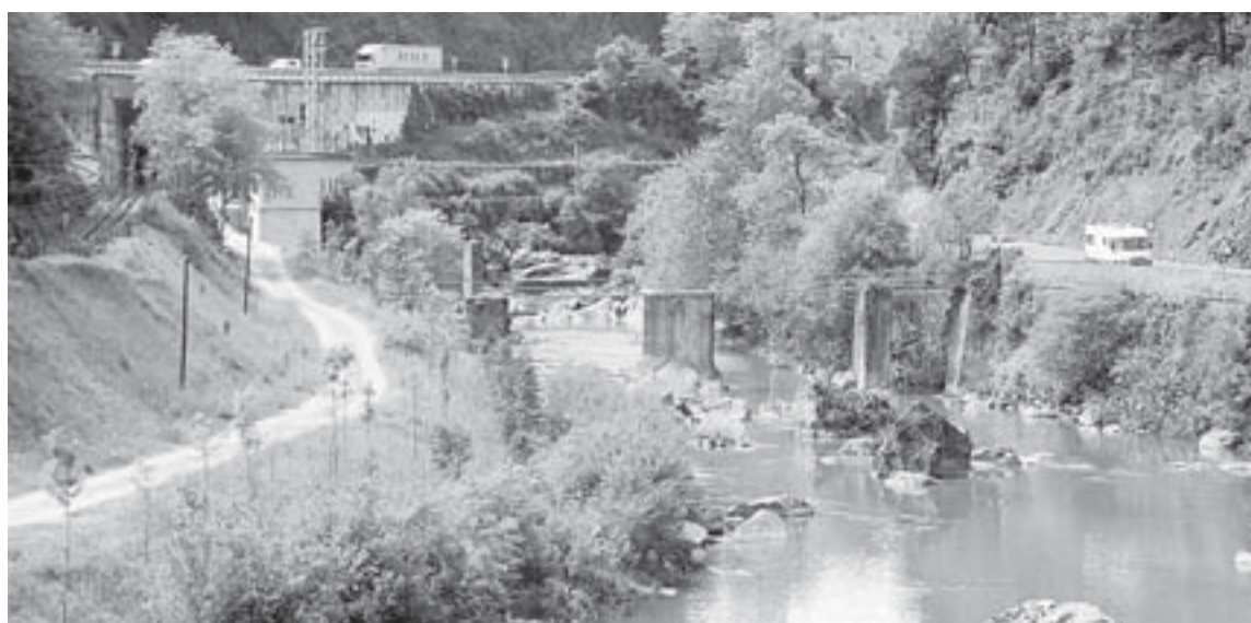
El bidegorri discurrirá en paralelo al río Deba y pasará junto a las centrales hidroeléctricas. [AITOR]
