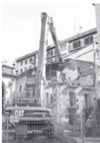
Labores de demolición. [AITOR]
